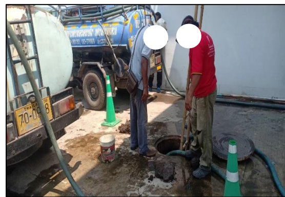
รูปที่ 2-9 การสูบน้ำจากระบบบำบัดน้ำเสียไปกำจัด
